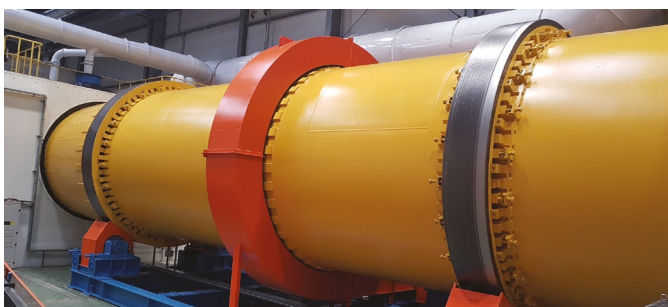
Монтаж выбивного барабана 300 т/ч
