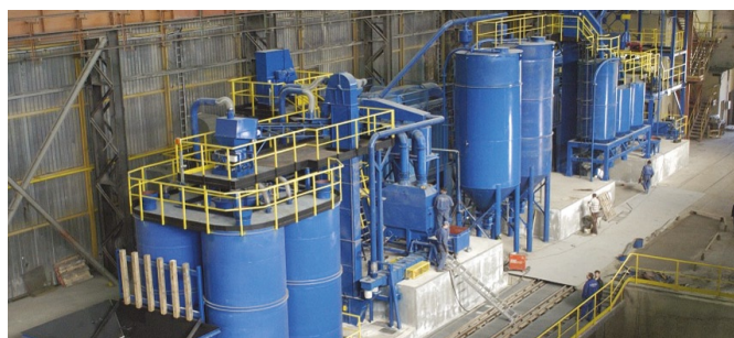
Монтаж линии покрытого смолами песка 4 т/ч
