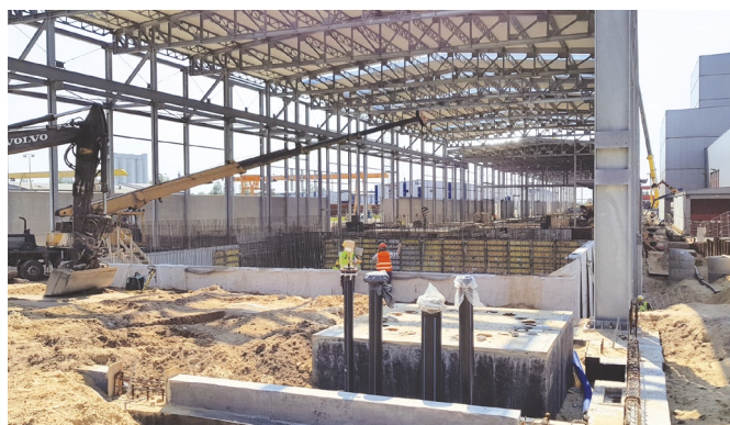
Строительство нового чугунолитейного производства
