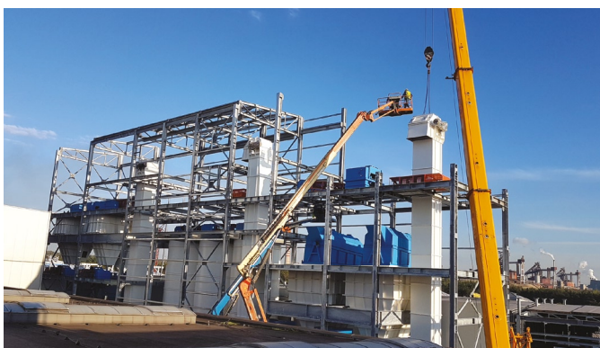
Монтаж станции приготовления формовочных масс 300 т/ч
