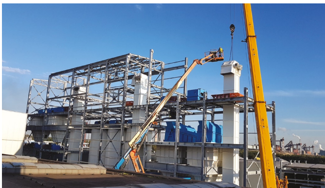
Montaż Stacji Przygotowania Mas Formierskich Q=300 t/h
