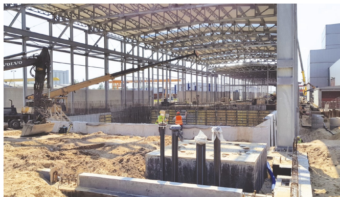
Budowa nowej odlewni żeliwa
