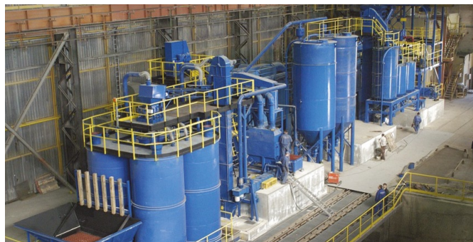
Montaż linii piasków otaczanych Q=4 t/h
