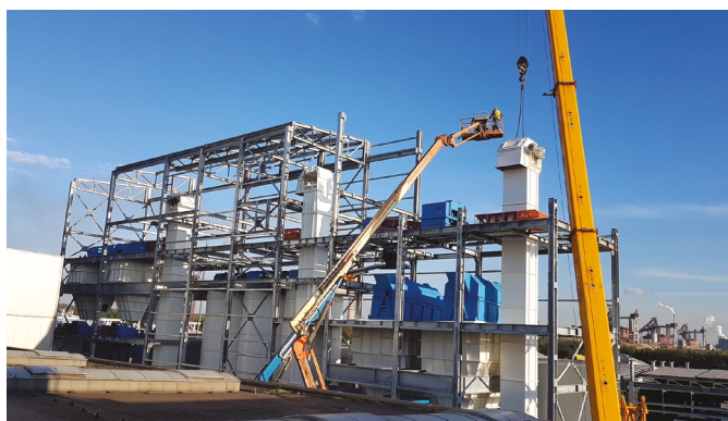
Montáž přípravný formovacích směsí Q=300 t/h
