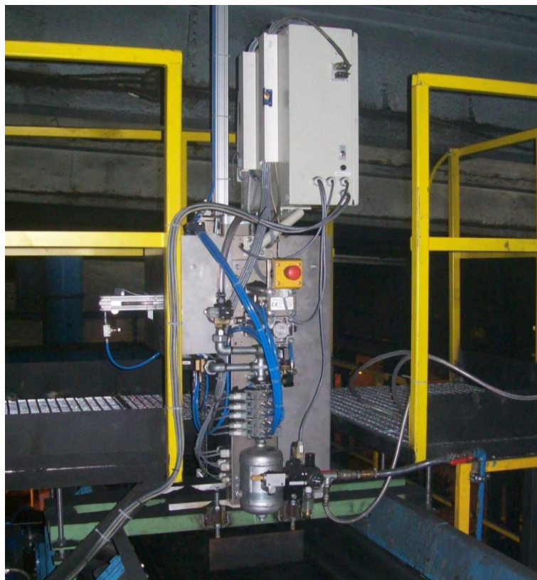
Rys. 6. System pomiaru parametrów masy VEDIMAT-4 zainstalowany na przenośniku taśmowym.
