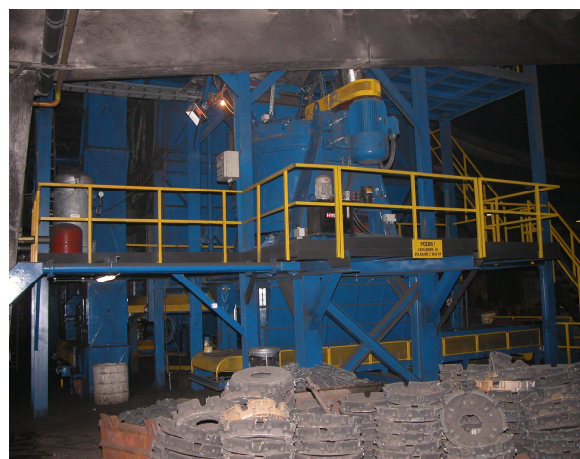
Rys.4. Zabudowa mieszarki turbinowej MTP-3000 w Zliefáreň Trnava s.r.o. – Trnava (Słowacja)
