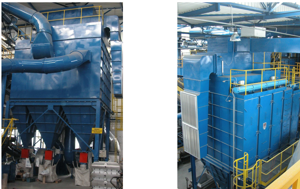
Rys.12. Filtry suche regenerowane impulsem sprężonego powietrza wraz z filtrem oczyszczania absolutnego
