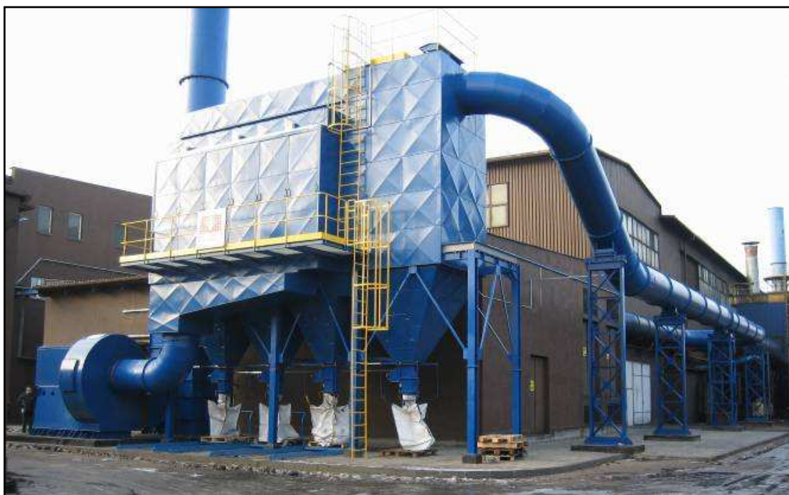
Instalacja odpylania pieców indukcyjnych
