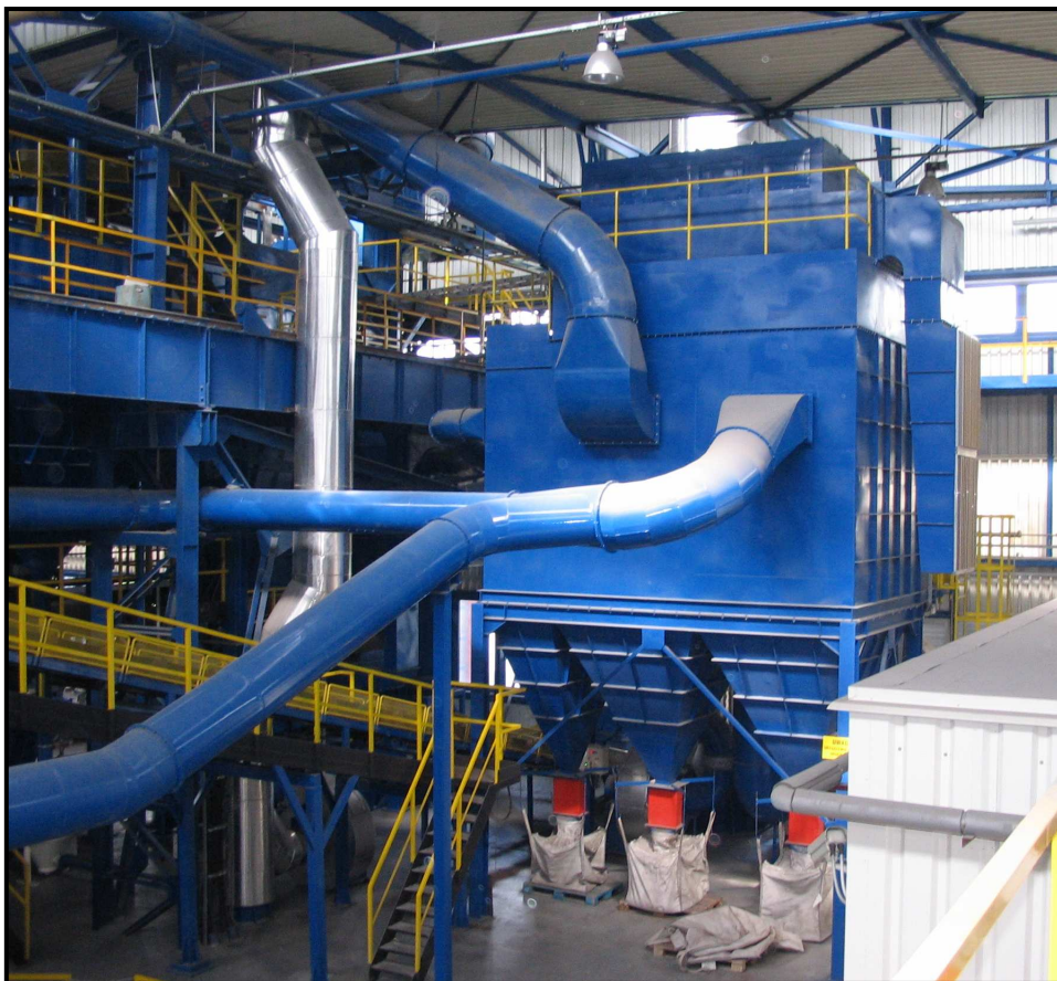
Instalacja odpylania linii zalewania, stacji regeneracji mas oraz chłodziarki mas formierskich
