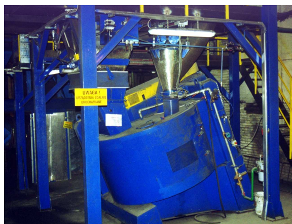
Rys.16. Zabudowa mieszarki turbinowej MTP-1500 w odlewni WSK PZL RZESZÓW:
