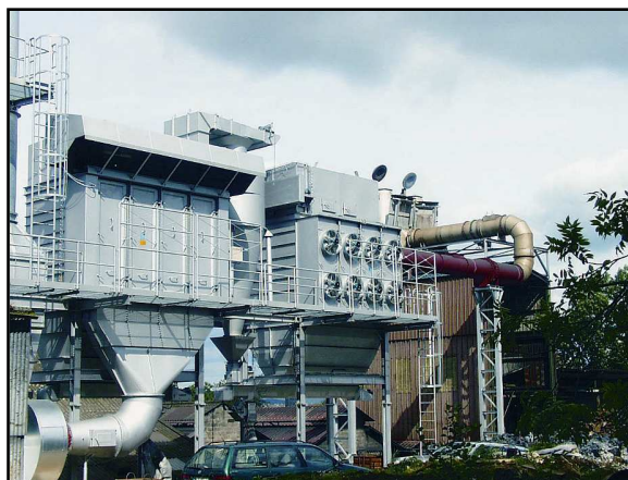
Rys. 9. Instalacja odpylająco-chłodząca gazy odlotowe z żeliwiaka.
