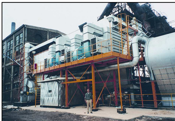
Rys. 10. Instalacja odpylania pieca przewalowego do produkcji tlenku cynku.
